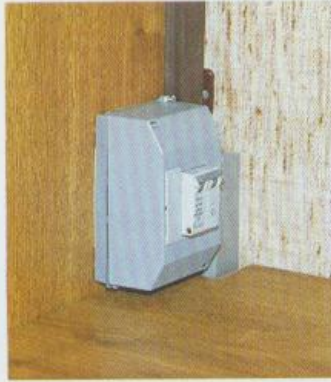
Sicherungsautomat.
